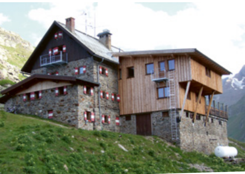
Unsere Langtalereckhütte im Ötztal/Österreich
